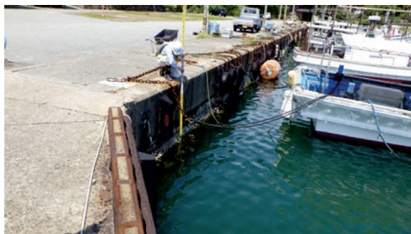
写真 1 地盤隆起量の計測状況
