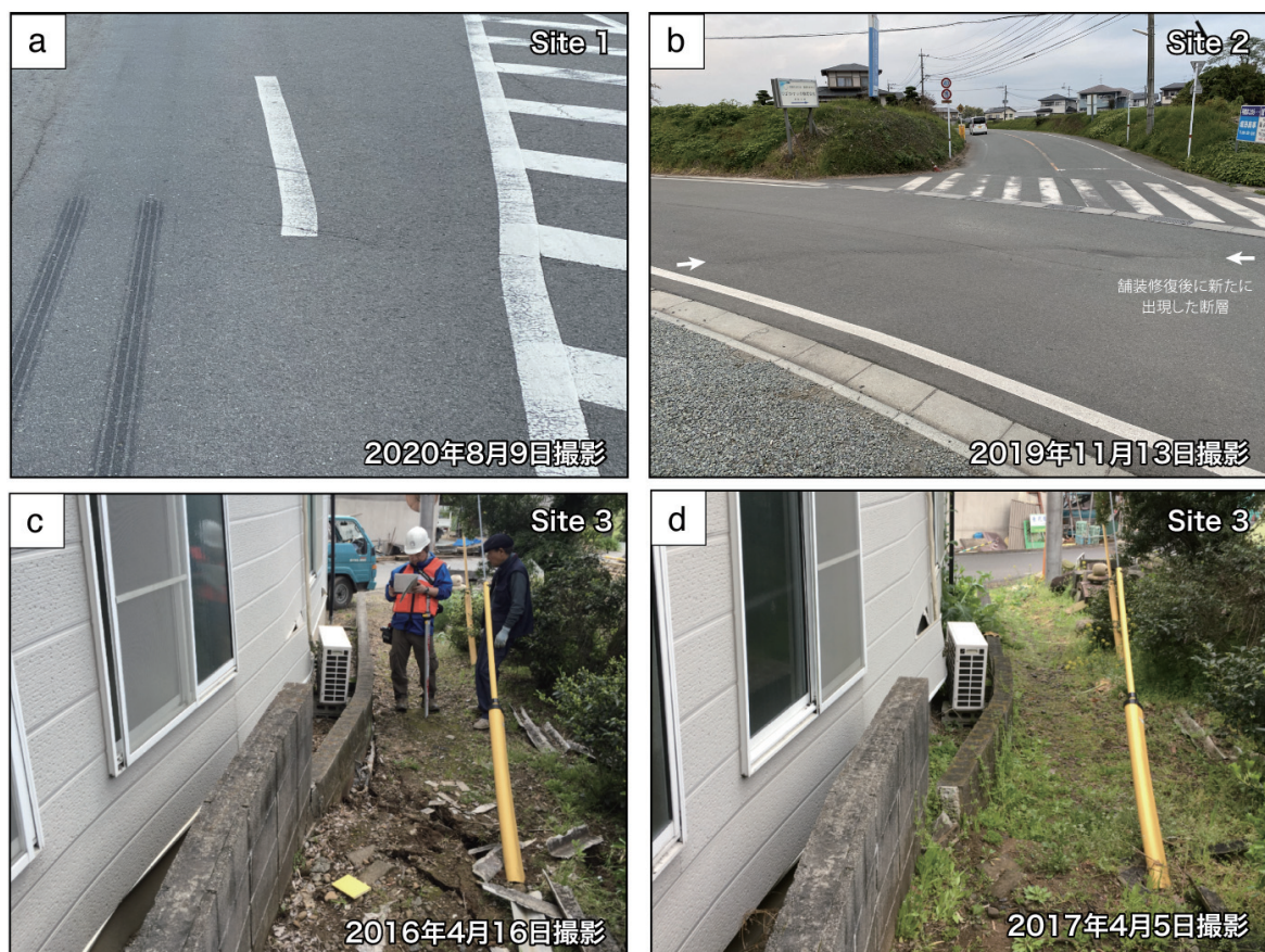
図1 余効すべりの写真. a) 益城町町道飯田東無田線上の右横ずれを示す車両通行帯白線と導流帯. b) 御船町高木地区町道小敷田西往還線上の補修路面に出現した雁行亀裂群. c) 御船町高木地区給油所裏のブロック塀の変位. 地震直後, d) 1年後.
