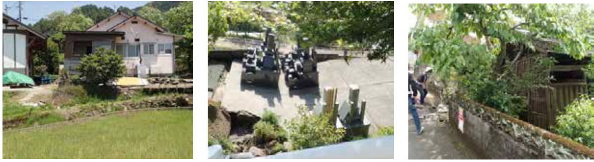
図-2 2016年熊本地震の地表地震断層ごく近傍の状況（変位の影響は大きい揺れは小さい）
