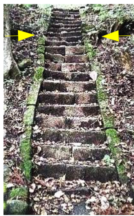
図2. 地震断層による八幡神社石段の変形。矢印部分の縁石が崩れている。
