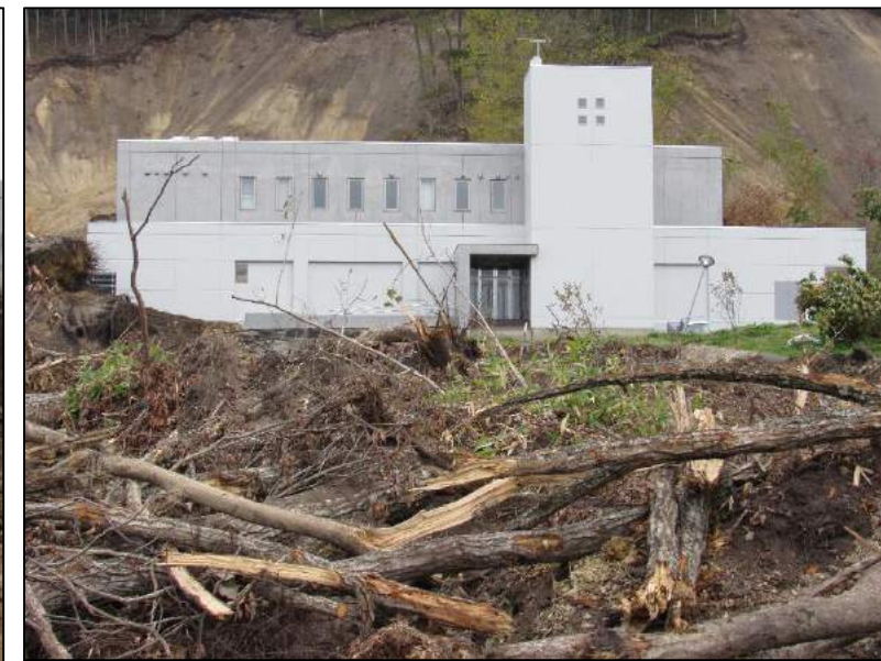
周囲を崩落地すべり体に囲まれた浄水施設棟(上:正面、左上:背後、左下:西側側面)
