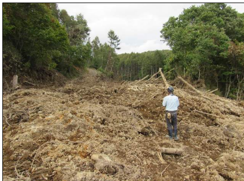
沢口の堆積状況 (印象として腐植土が多いように見える)
