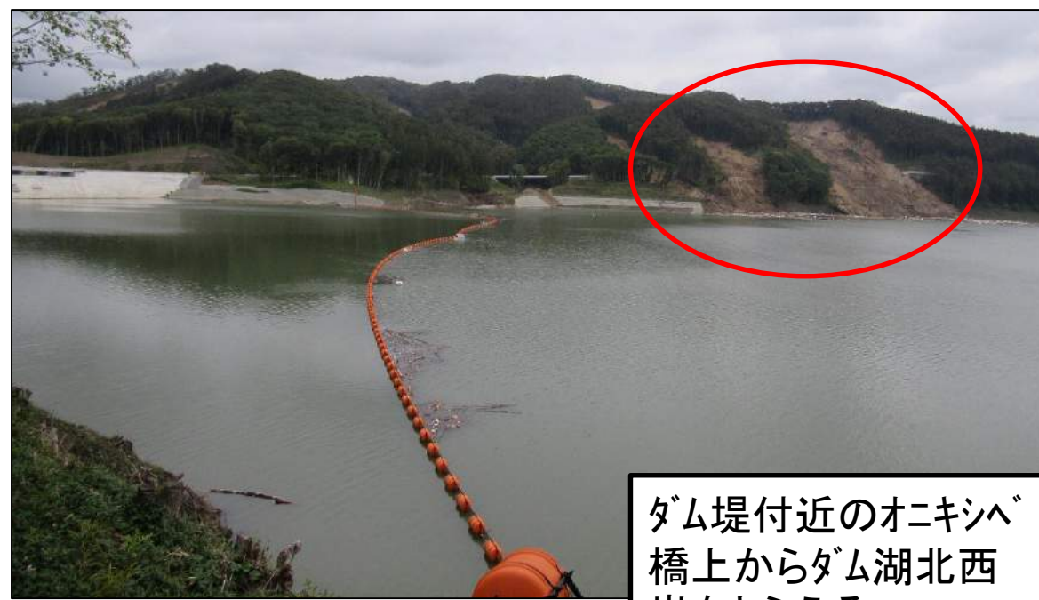
南西側湖岸斜面の崩壊
