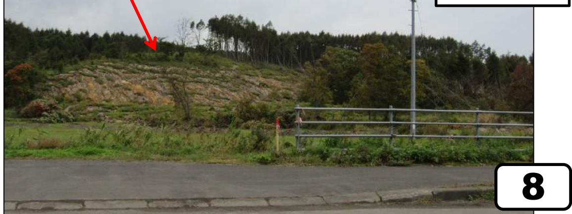
崩壊した斜面部(斜面草付き表層が虎模様状に残る)
