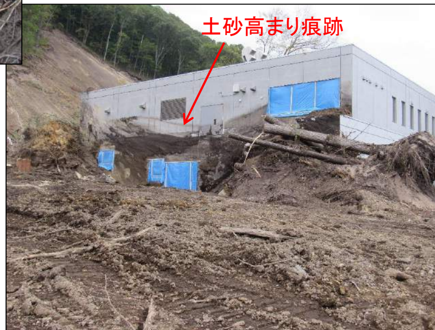
転倒し約70m押し流されたコントロール施設
