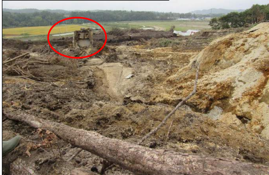
給水塔よこから続く流水跡(コントロール施設が横たわる)
