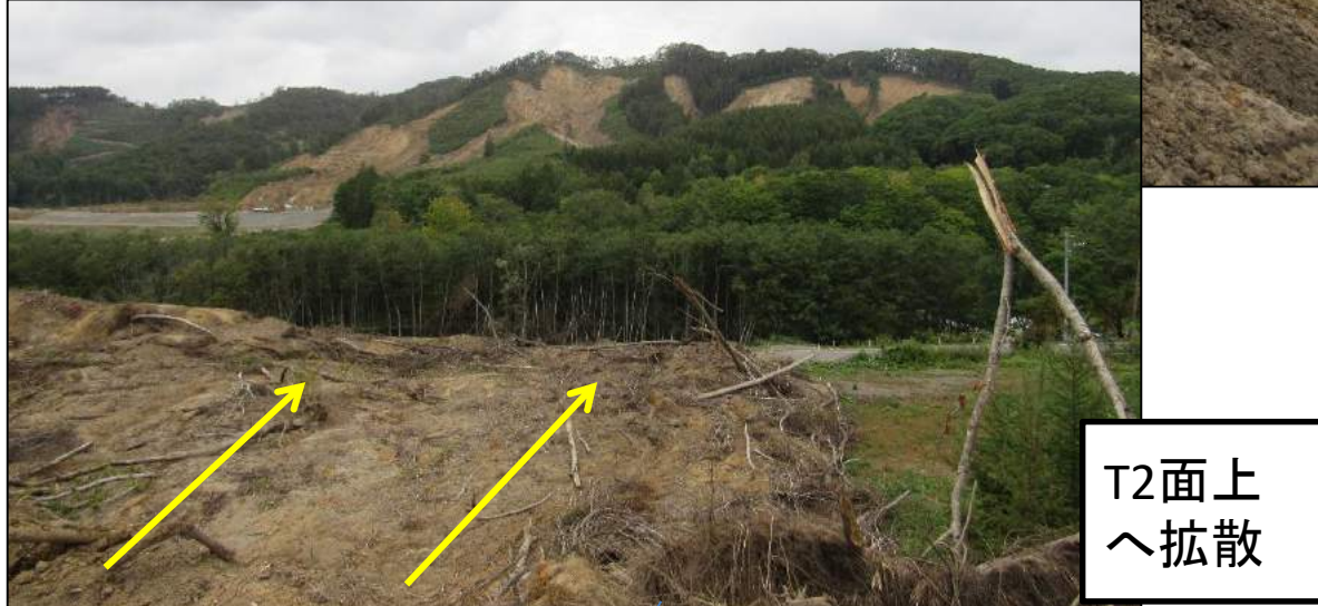
地すべり体の道路乗り越え・堆積(除去)
