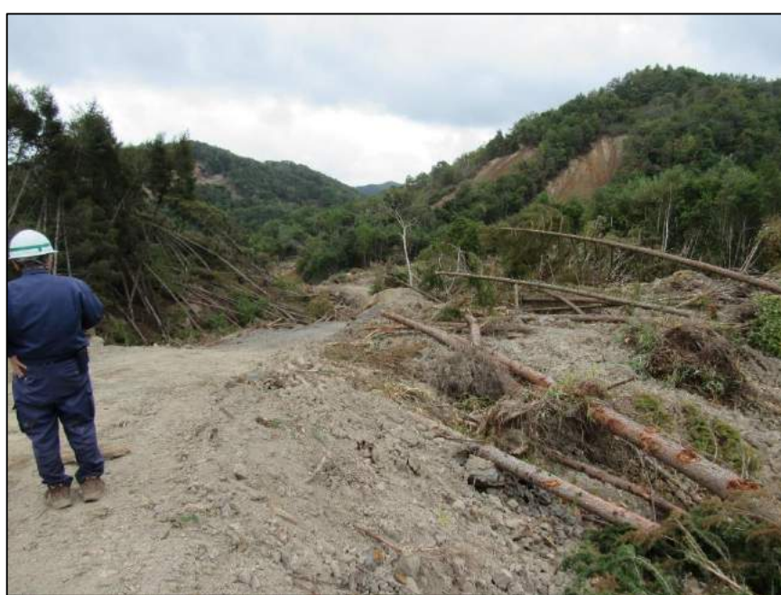
仮設道路峠(地すべりブロック軸部)から上流側を望む
