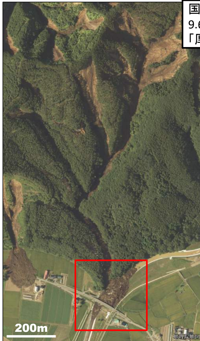
幌内集落北側の空中写真
