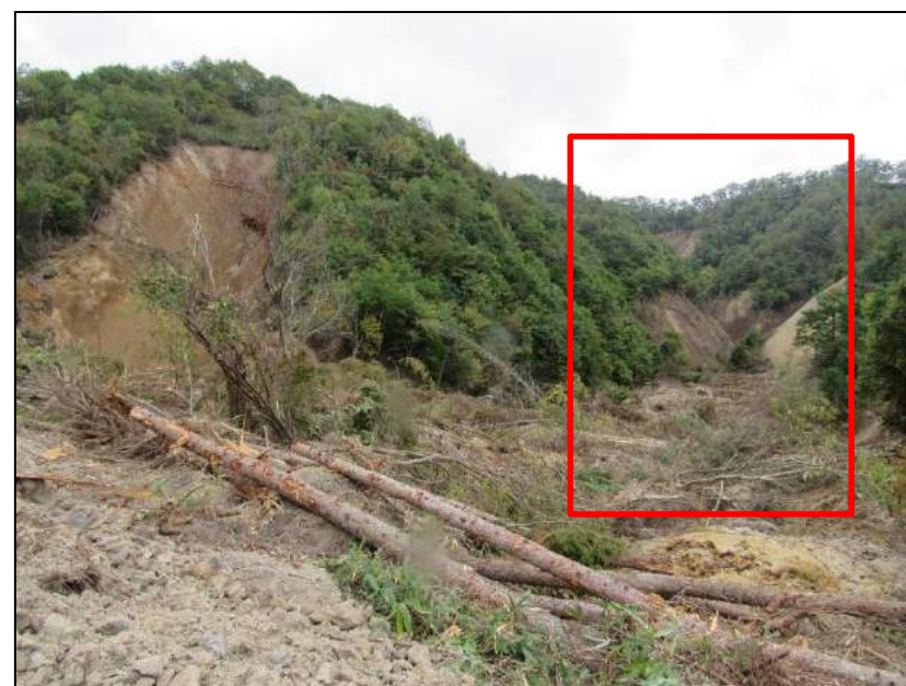
南側の崩壊・地すべり沢も北からの大規模地すべりブロックにより塞がれた
