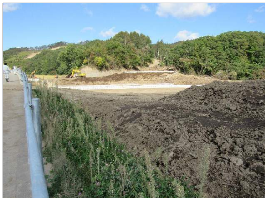
橋南東側取付部から沢口を望む
