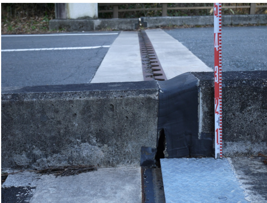
写真・4 新小山橋 西側橋台 5 cm 西落ち、4cm 引張
