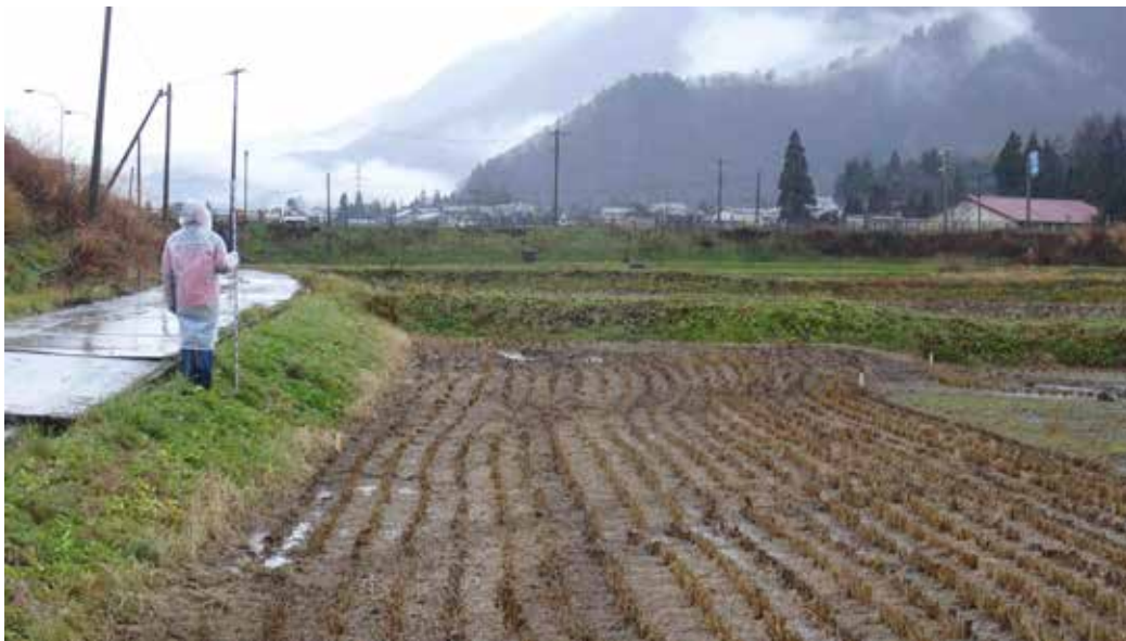
写真 2.北西走向の地震断層沿いの水田の変位（上下変位量は30-40cm，右横ずれ30~40cm程度）。
