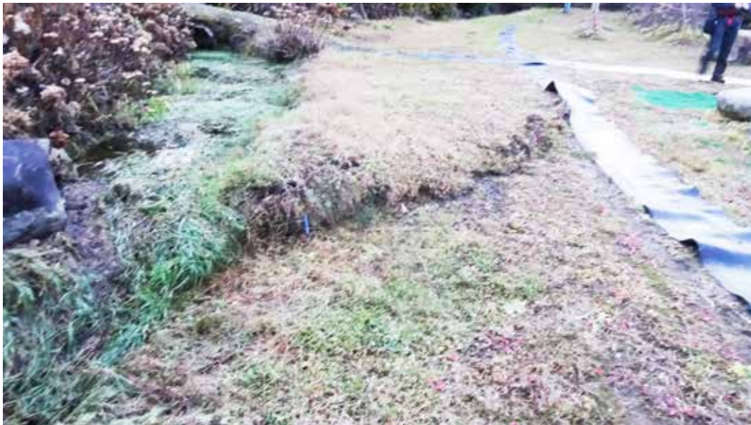
写真 4.地震断層南部部地域の露頭。上下変位約 25cm。
