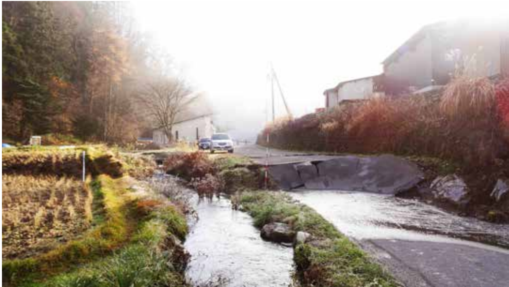
写真 1.北東走向の地震断層沿いの水田と道路の変位（東側隆起70-80cm 程度，右側の道路中央部の小川と水田のあぜ道に左横ずれ約 65cm）。
