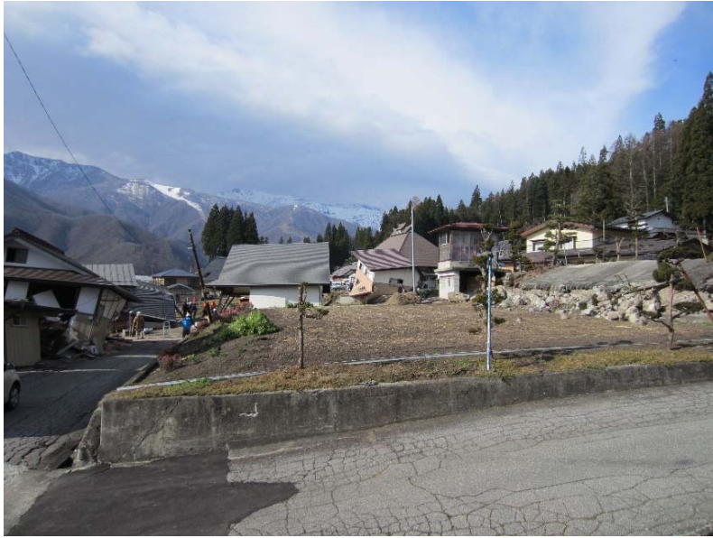
写真2：堀之内地区の被害 (堀之内地区から写真1 地点方向を望む。)
